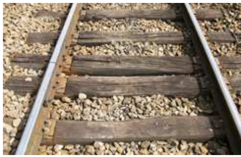
Rails courts sur traverses bois
